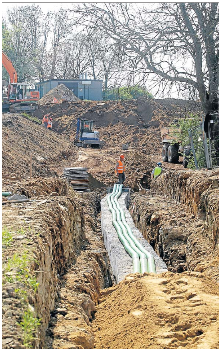
Die Telekommunikationsleitungen der Post mussten neu verlegt werden.
