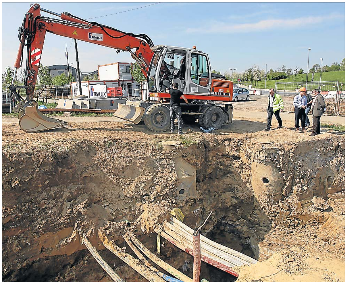
Von Dezember bis jetzt wurde an der Umleitung der Versorgungsleitungen gearbeitet.
